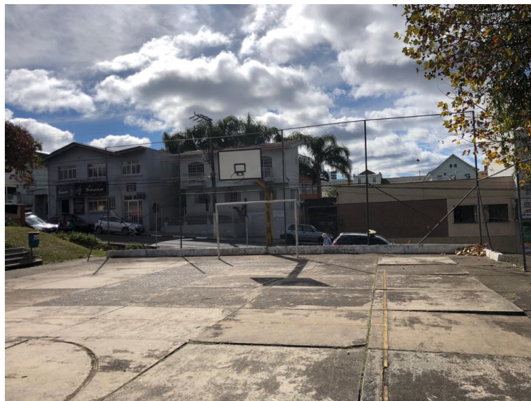
Figura 04 – Quadra existente que deverá ser demolida (Fonte: Autora/2021)
