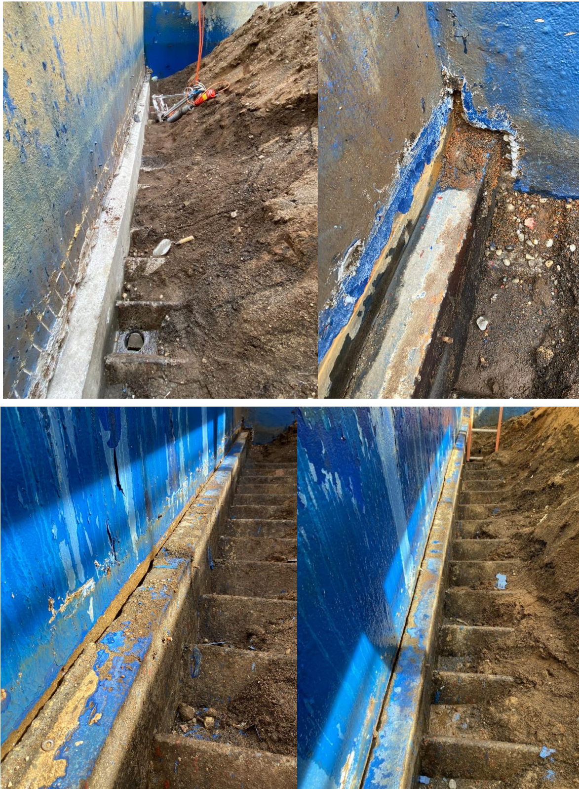
Figura 1 – Situação estrutural e operacional dos filtros da ETA 1.
