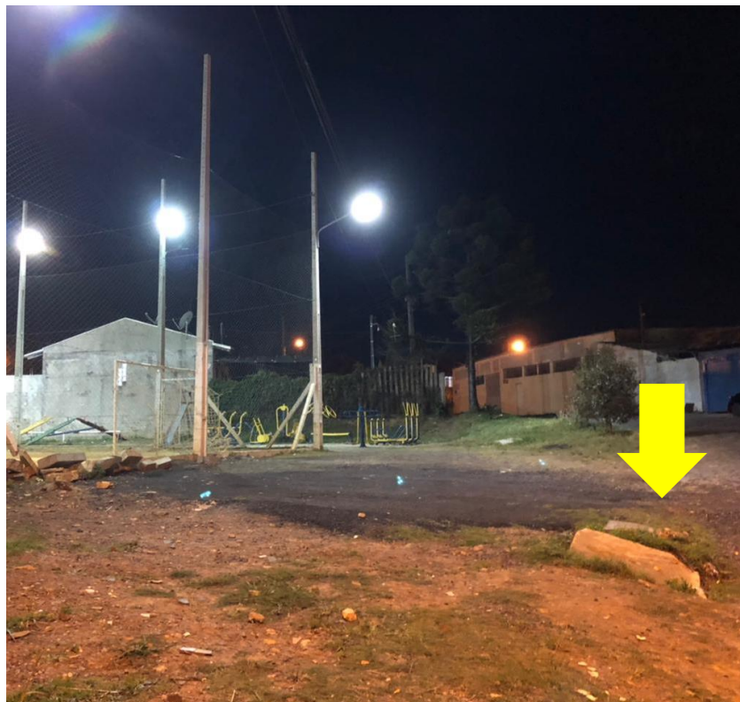
Figura 06 – Foto da rede pluvial existente (Fonte: Autora/2021)
