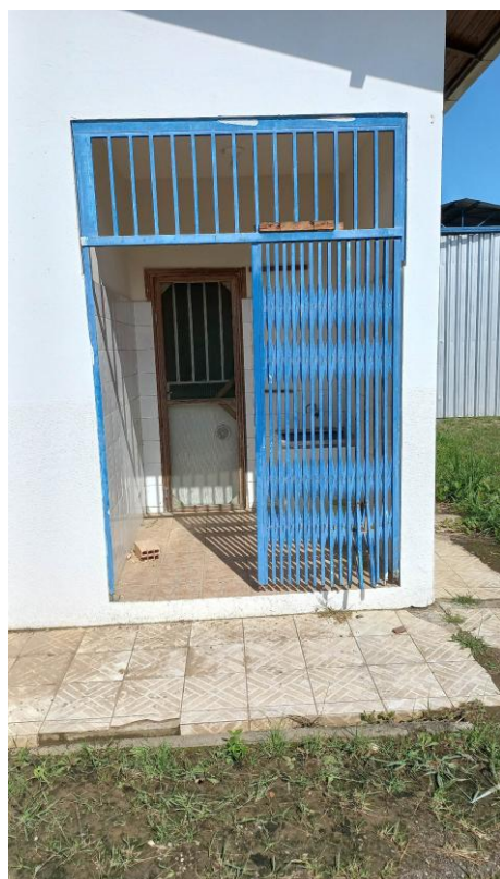
Grade sanfonada reforma, tela mosquiteiro nas portas e janelas da cozinha com sarrafos de angelin.
