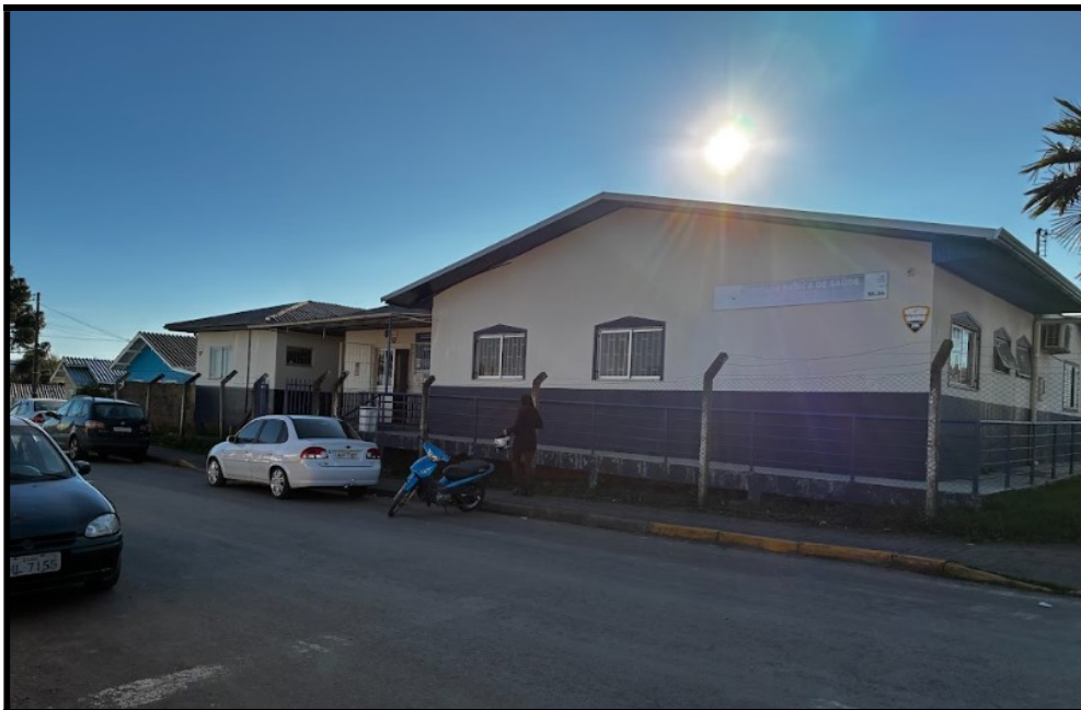
Foto 01 – Frente da edificação existente
