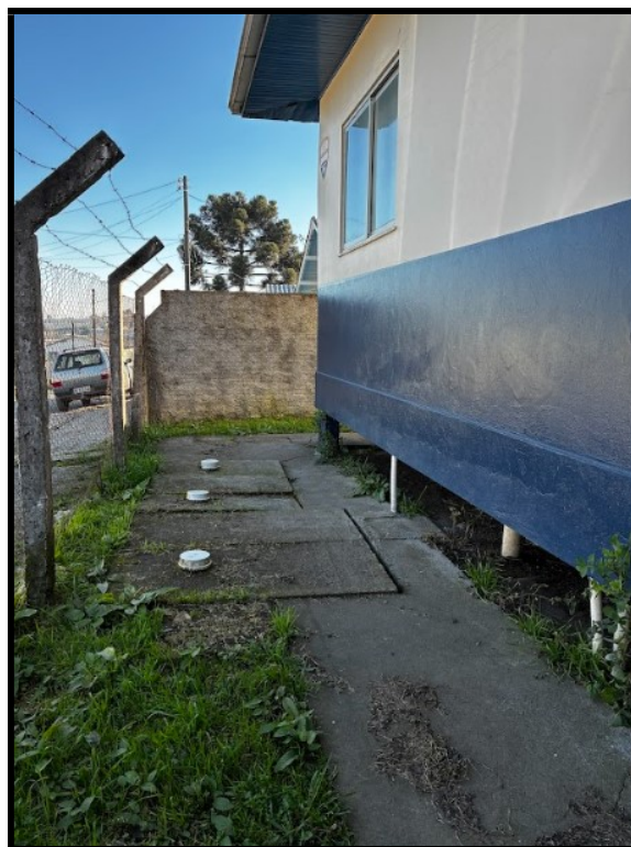
Foto 03 – Fossa, Filtro e Sumidouro existente.
