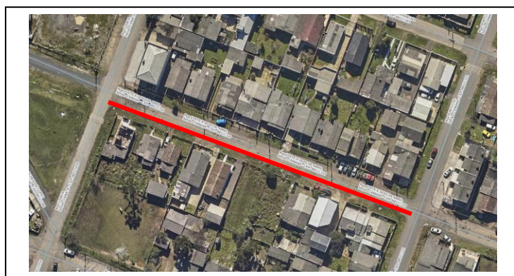
Figura 1- Localização da área de intervenção (trecho grifado)
