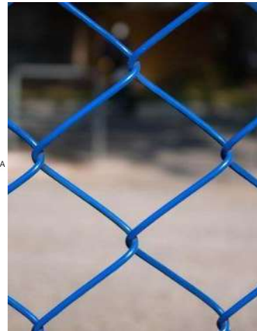
Figura 07 – Detalhe de alambrado (Fonte: Autor/2025)
