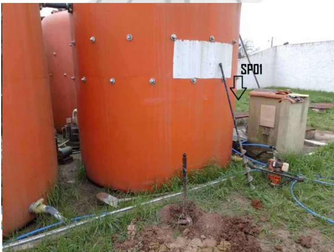
IMG02 – Início da perfuração SP02 e locação SP01
