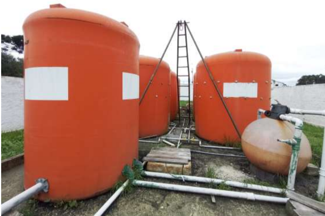
IMG01 – Execução SP03
