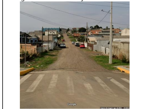
Figura 3- Foto Rua Projetada – Est. inicial
