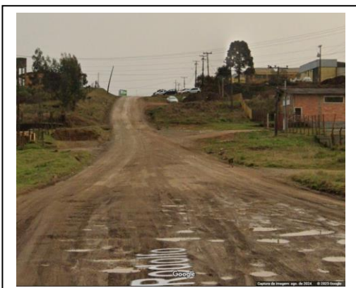
Fonte – Google Street View. (Imagem Ago. 2024).
