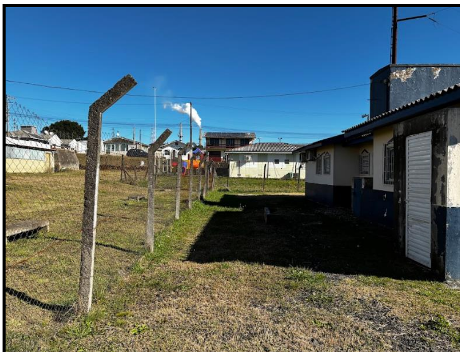
Foto 03 – Fundos onde será ampliado a edificação e a delimitação do terreno.
