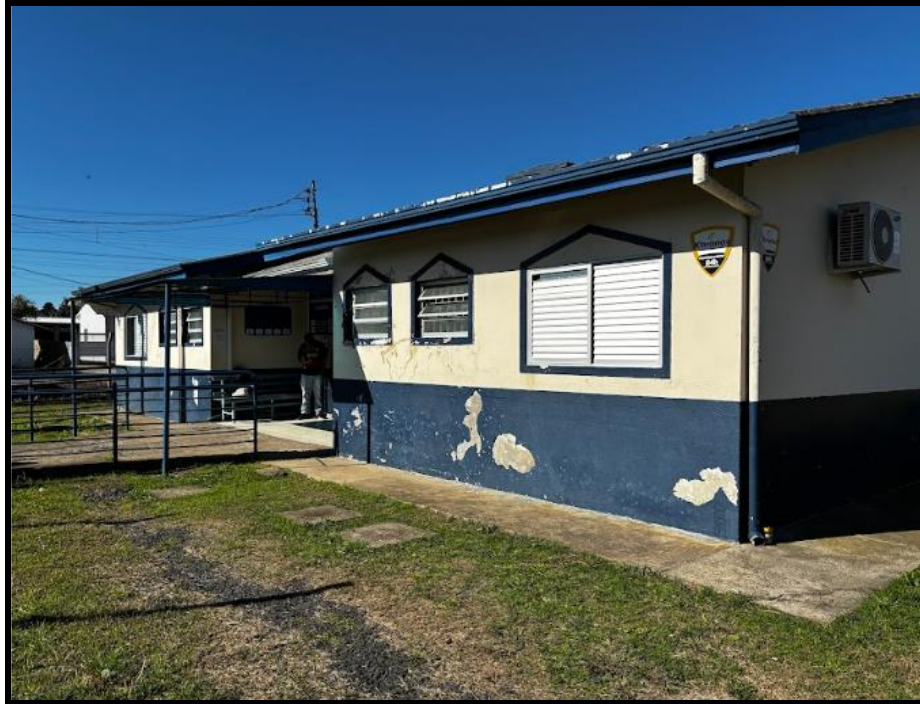
Foto 01 – Frente da edificação existente
