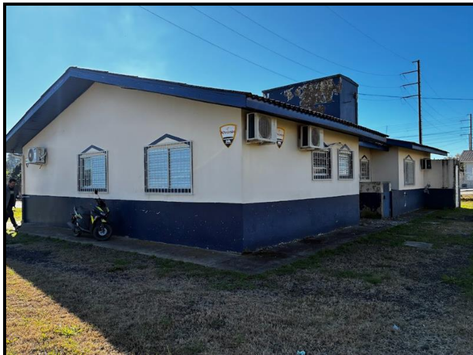
Foto 02 – Fundos e lateral direita da edificação (local onde será feito a ampliação)
