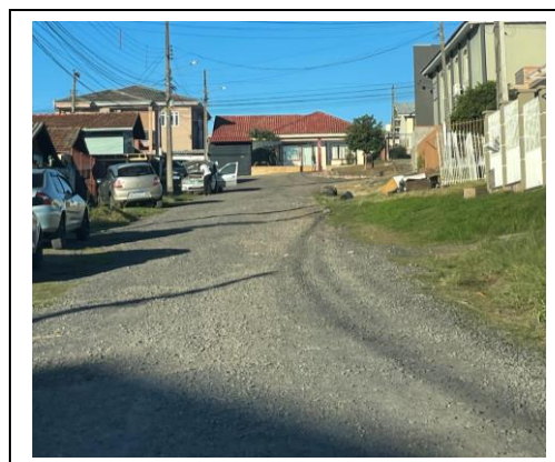
Figura 2- Foto Rua Projetada - Final
