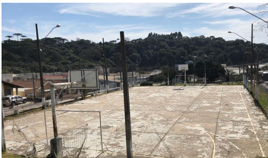
Figura 04 – Quadra existente que deverá ser revitalizada (Fonte: Autora/2021)
