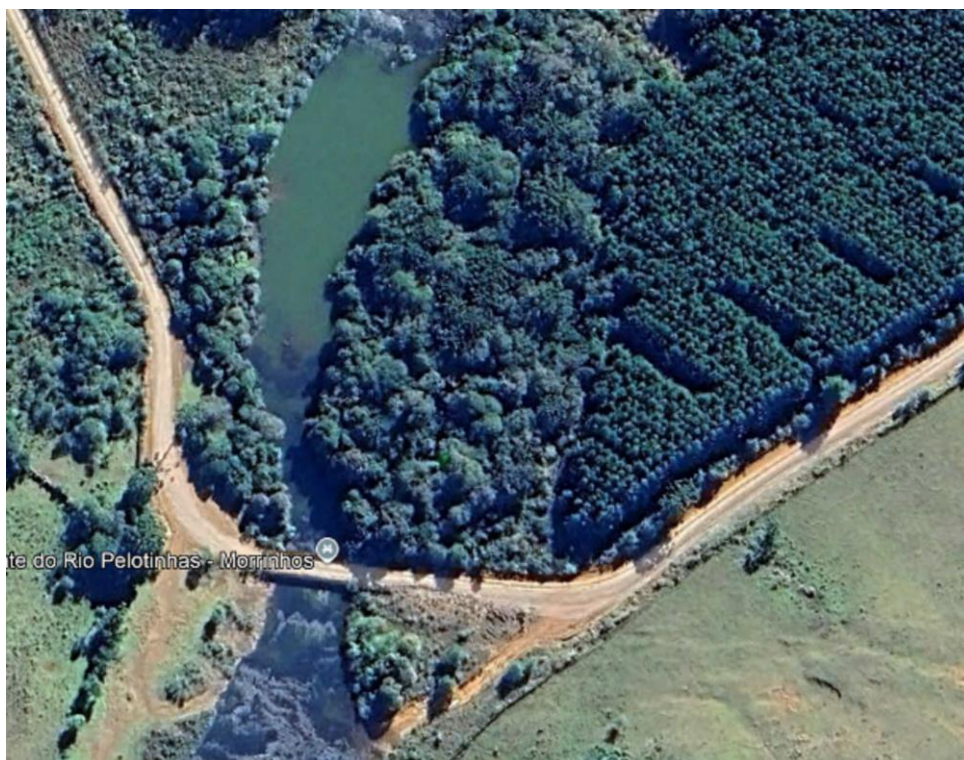
Foto 3: O Apoio 2 localizado na coordenada geográfica latitude -28.036930 e longitude -50.278243 na Estrada Geral de Morrinhos.
