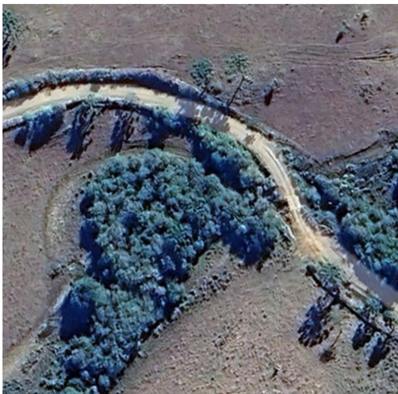
Foto 4: O Apoio 8 localizado na coordenada geográfica latitude -28.239507 e longitude -50.387450 na Estrada Geral de São Jorge.
