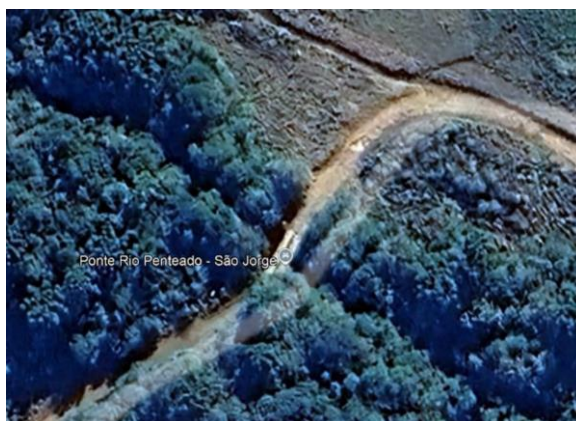
Foto 2: O Apoio 4 localizado na coordenada geográfica latitude -28.276932 e longitude -50.441558 na via de ligação entre a Estrada Geral de São Jorge e a Estrada Geral do Bodegão.
