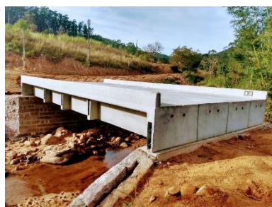
Foto 1: Kit ponte instalado sobre cabeceiras
