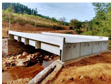
Foto 1: Kit ponte instalado sobre cabeceiras
