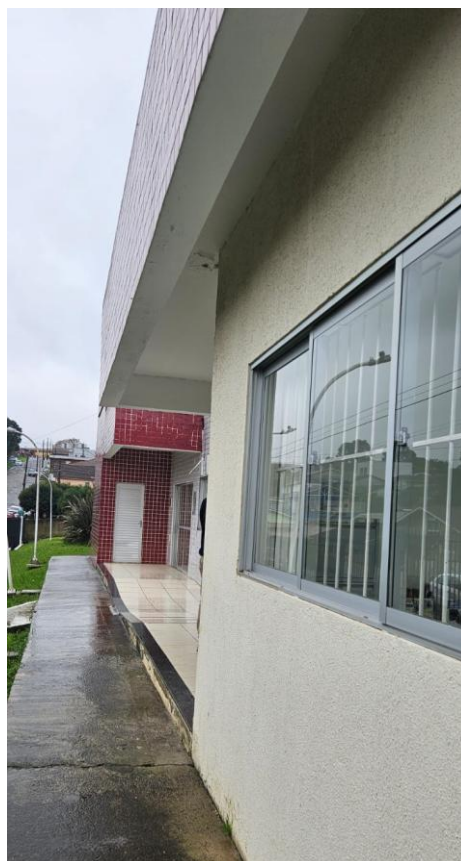
Fotografia 04 – Vista geral do acesso principal
