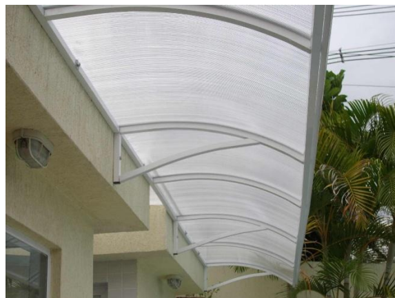
Figura 6 – Vista inferior de cobertura curva em policarbonato alveolar
